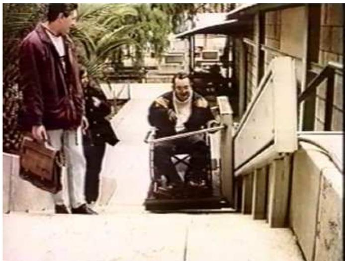
Figura 5.15 Las servoescaleras se han convertido en una solución muy adecuada para salvar obstáculos en edificios que por su naturaleza es imposible realizar reformas o introducir rampas.
